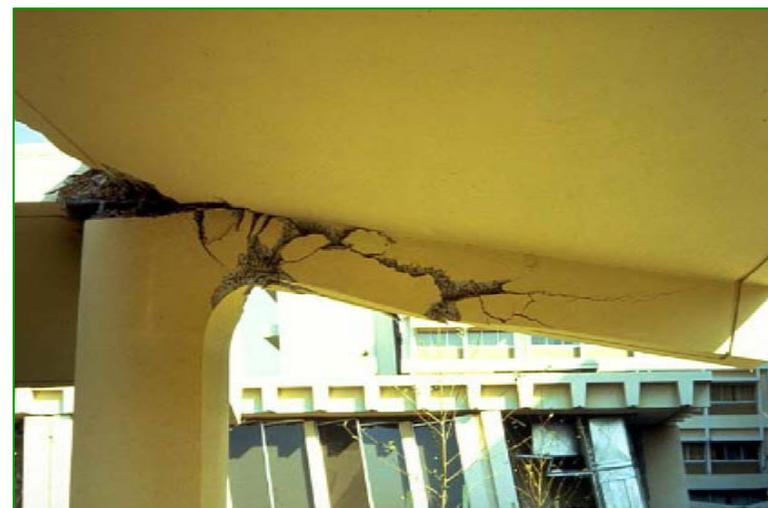
**mancanza di un adeguato ancoraggio delle barre di armatura**
